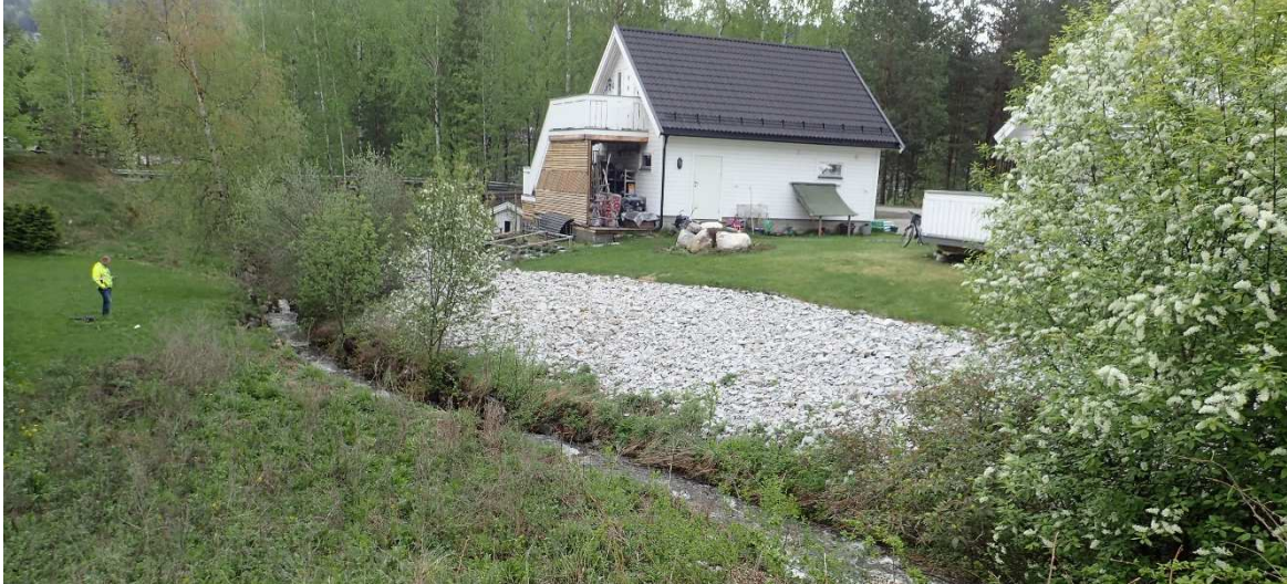
Figur 4 Området oppstrøms innløpet til bekkelukking del 3, Sundheimsvegen i bakgrunnen
