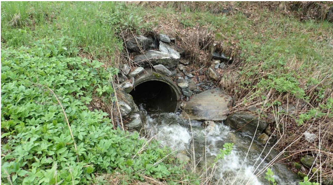
Figur 5 Innløp til eksisterende bekkelukking del 3
