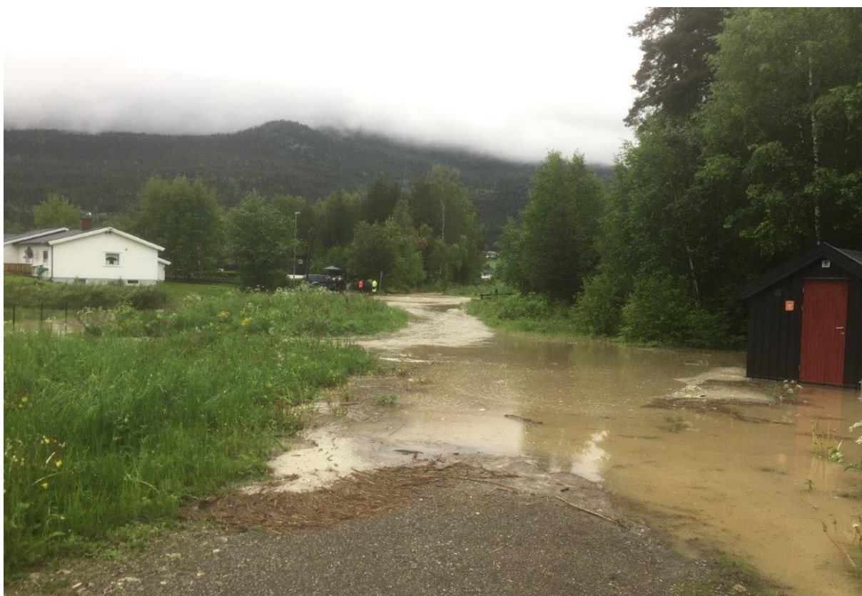
Figur 1: Bildet viser flomhendelse i Givra ved tilkomst fra Skåbuvegen, fv. 255 (Foto: Nord-Fron kommune).
