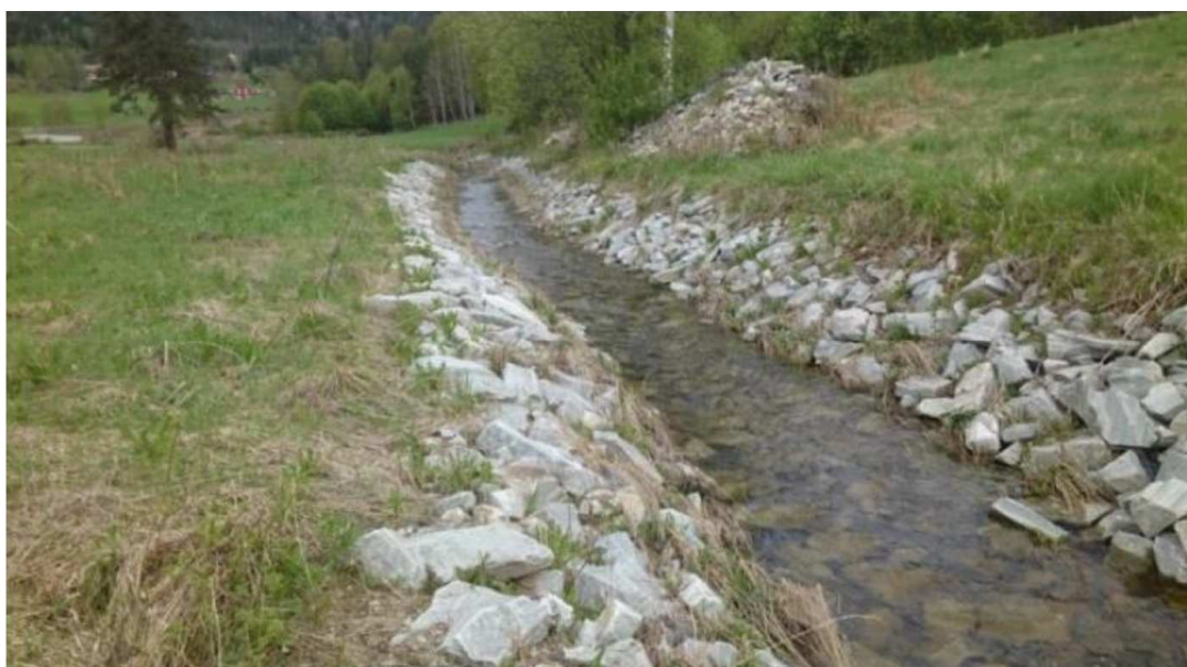
Figur 2 Givra oppstrøms tiltaksområdet
