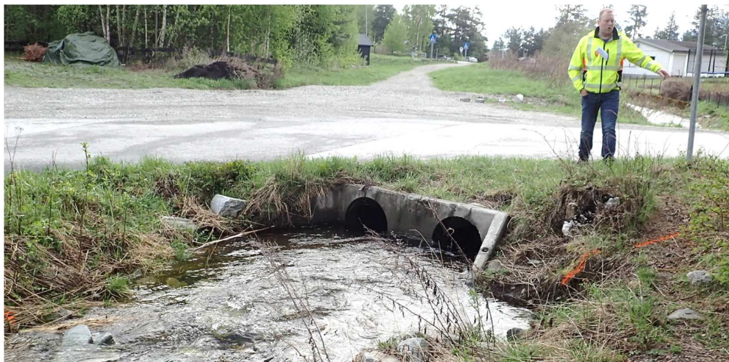
Figur 20 Dobbelt kulvert der Givravegen krysser Givra
