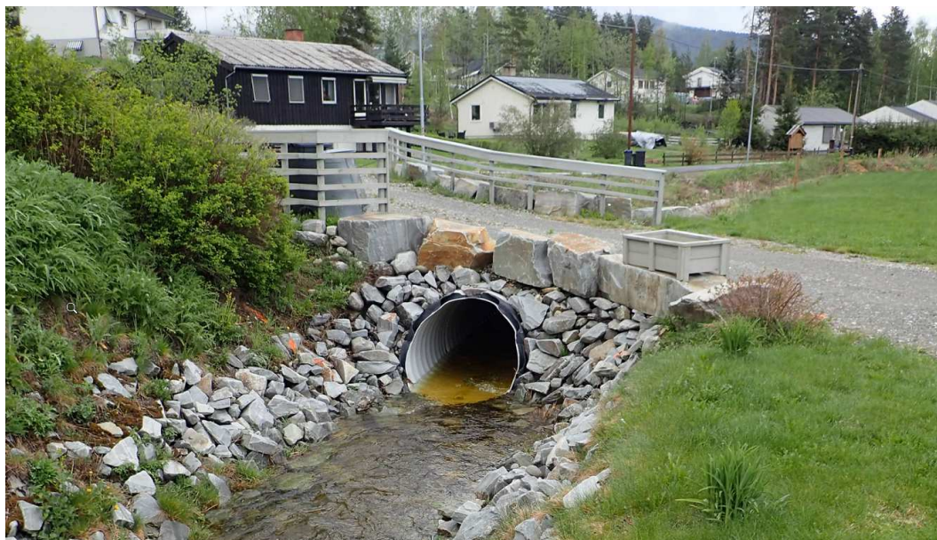
Figur 18 Eksisterende privat kjørebro til Givravegen 23
