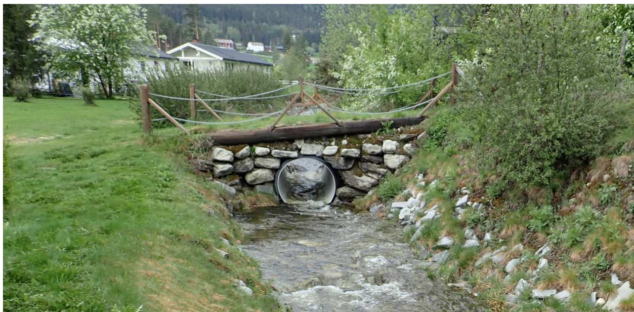
Figur 17 Privat gangbro til Lohaugvegen 22 blir fjernet
