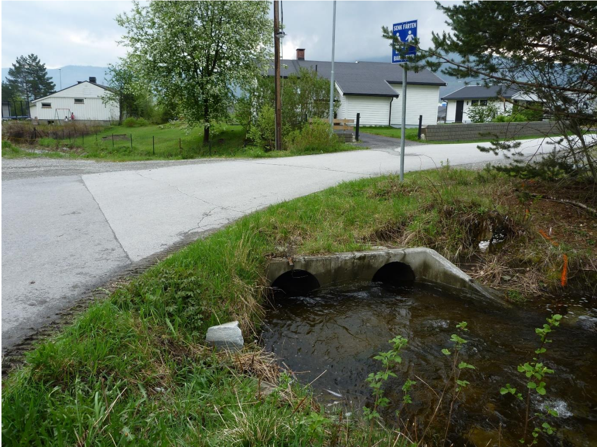
Figur 10: Selv med moderate vannmengder er det flaskehalser. Foto: RiK/WSP
