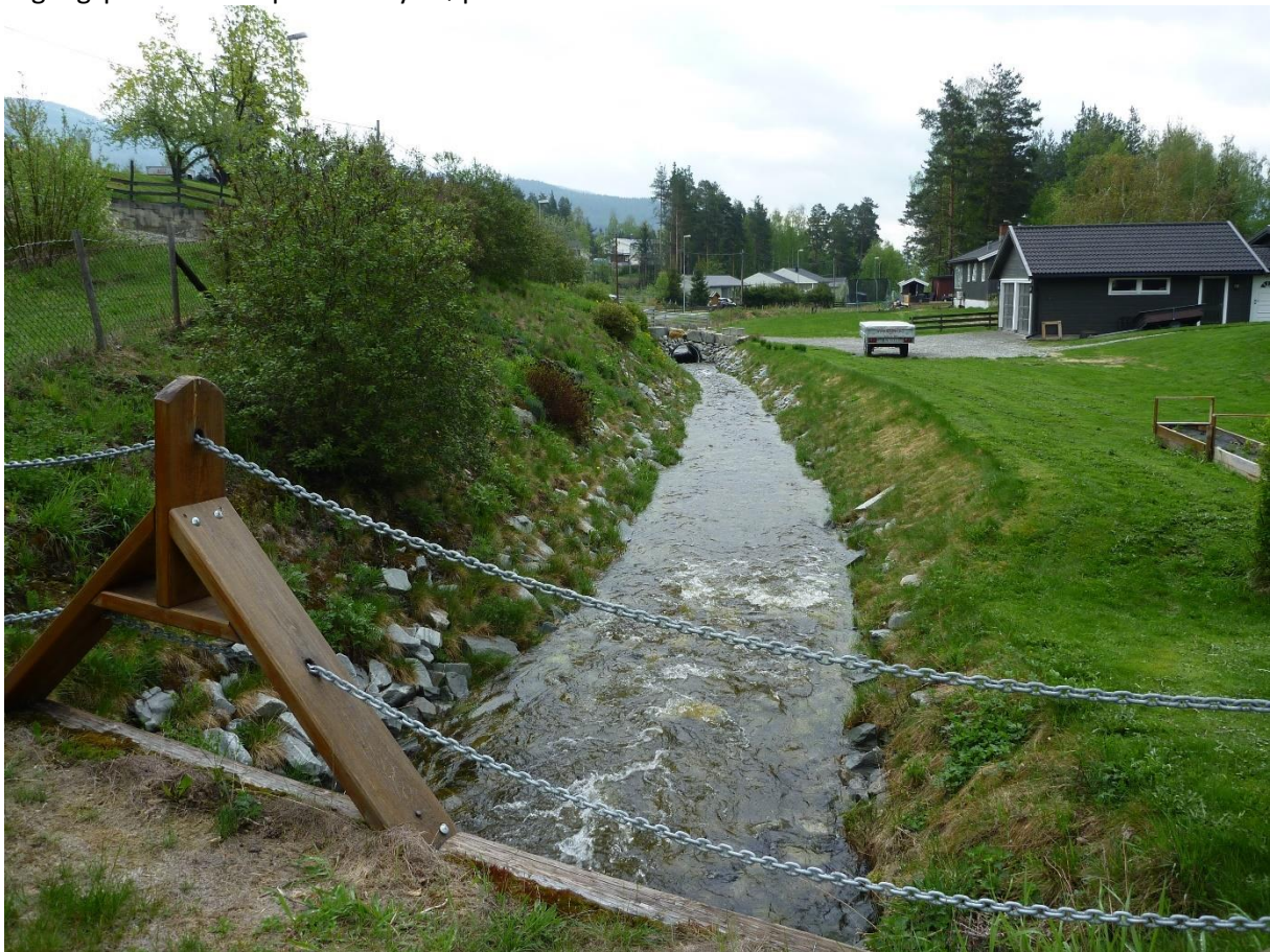
Figur 16: Det er allerede utført flomsikringstiltak i elva, slik at det opprinnelige elveløpet er erstattet. Foto: RIK/WSP.
