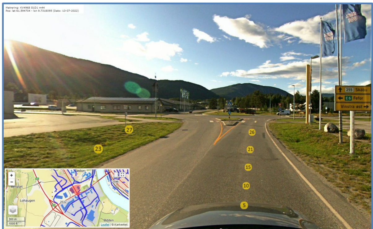
Foto: Kv4968 Lomovegen
