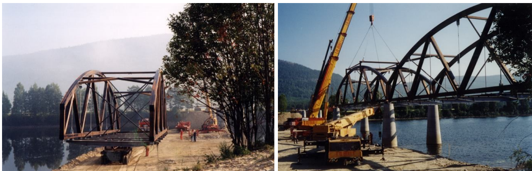
Figur 6-9 Evenstad bru under bygging. Kilde: Moelven
